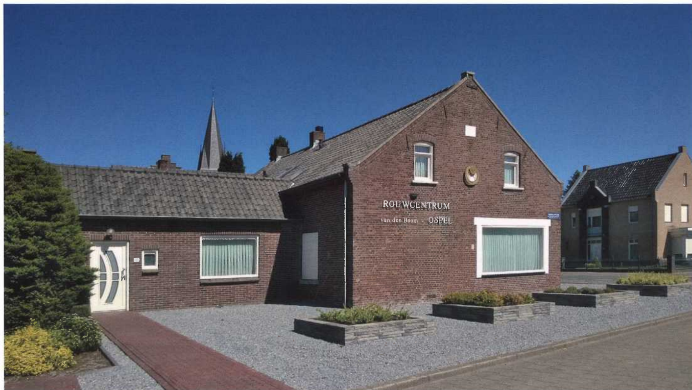
Het door Jan Aerthijs (1806-1885) in 1879 gebouwde huis, thans Rouwcentrum Van den Boom Ospel, diende als woning voor hem en zijn broer Henry en zus Digne. Het pand heeft daarna o.a. dienst gedaan als kapelanie en onderwijzerswoningen voor de meesters Derksen en Pil. Foto: Bert van Laer.
