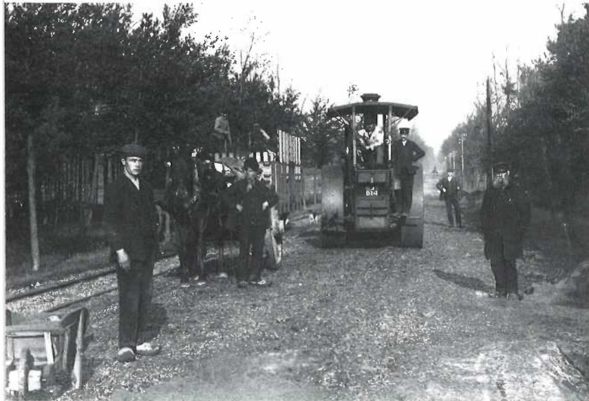
Kantonniers aan het werk bij de aanleg van de Rijksweg tussen Venlo en Velden omstreeks 1900. De man rechts met pet, baard en pijp is de opzichter Leonardus Ledant (1836-1914).
