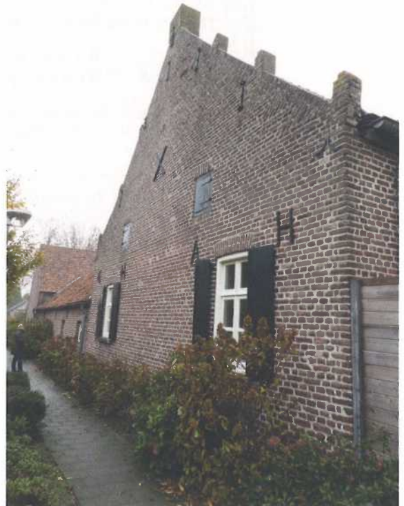
De kopse kant van de Schreurshof te Leveroy met de muurankers G H en A H bekeken door de plaatselijke historicus Johan Slabbers.
