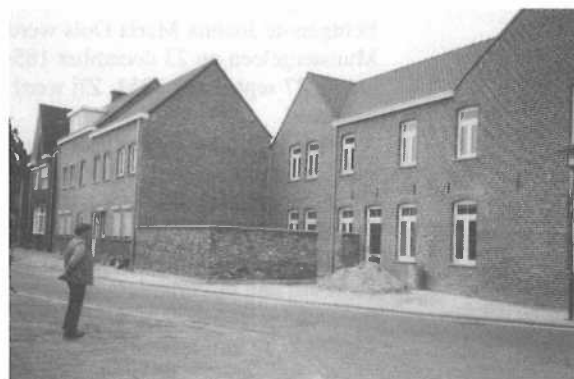
Hetzelfde hoekpand (verkocht in 2003) na de grondige renovatie en verbouwing tot appartementen. Annie Pelzers-Strijkers kijkt met belangstelling naar de vorderingen.
