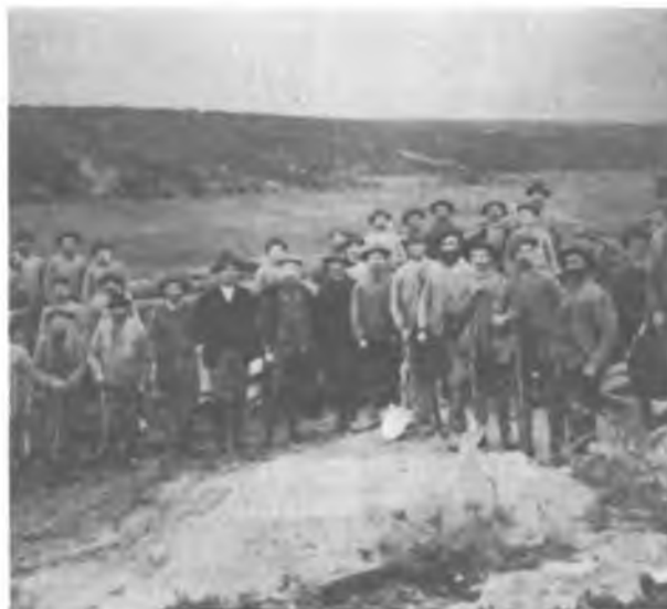
Graafwerkzaamheden voor het Julianakanaal te Born. In het midden op de voorste rij: Theodoor Ubachs, met lange, zwarte jas, en hoed op. Hij is de opzichter van de ploeg. Generatie XIII-E.
