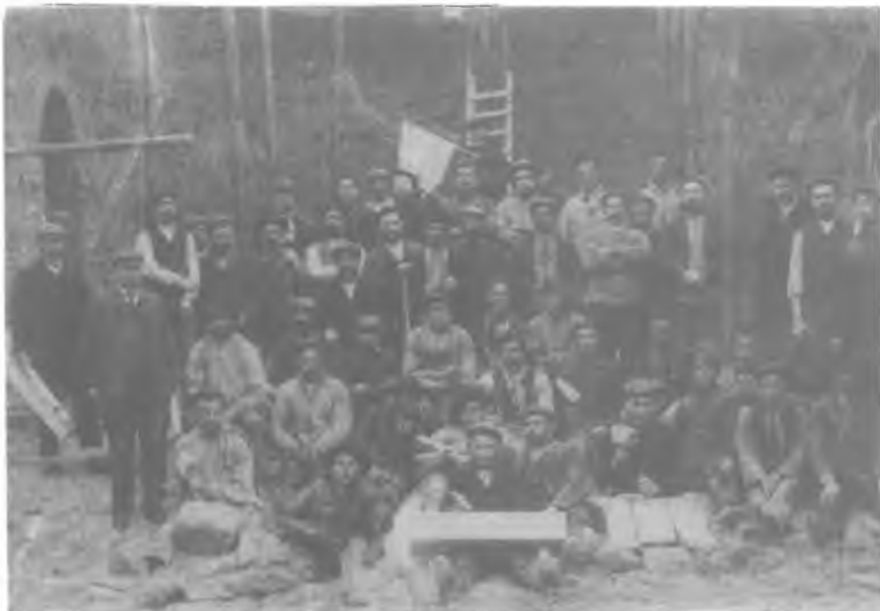
Bouw St. Corneliuskerk Heerlerheide 1909. De werklieden poseren op 17 april voor een groepsfoto op het priesterkoor in aanbouw. Links vooraan staande Leonard Ubachs opzichter (IV-10).
