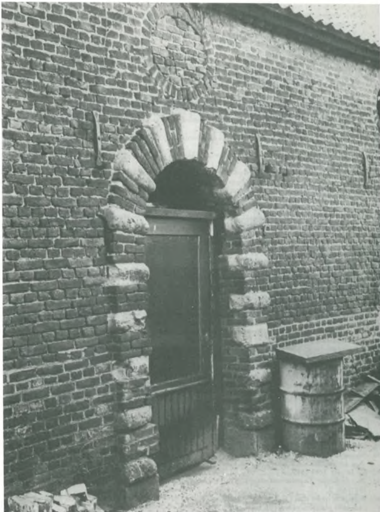
Het enige overblijfsel van de Neerbeekerhof. De rondboogingang, versierd met bossage blokken, van de bergplaats aan de Dorpstraat nr. 61a. Toestand in 1976.
