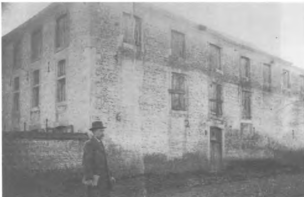
Westgevel alsmede aanzet noordgevel buiten vanuit noorden langs de Dorpstraat.
