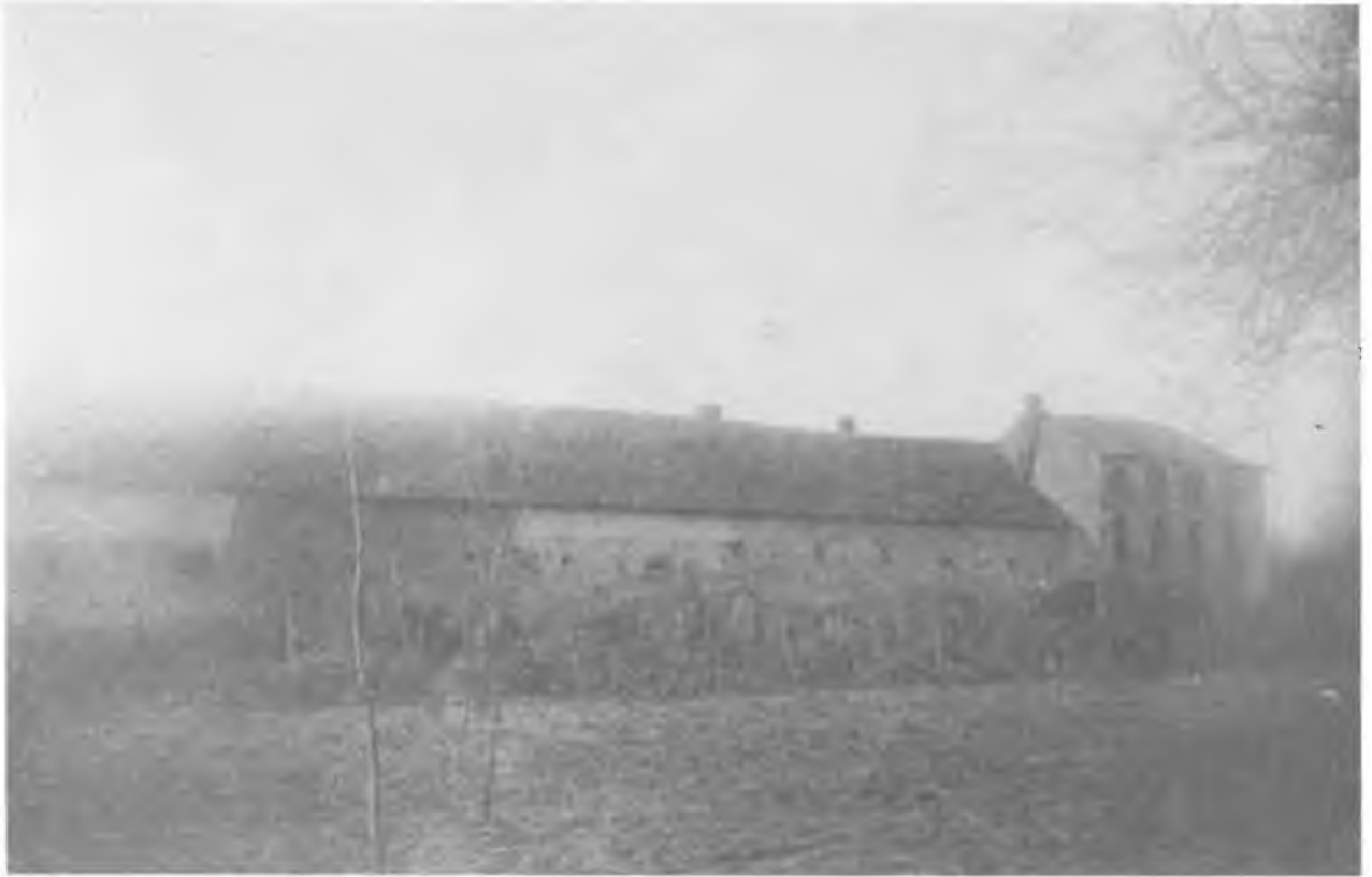
Noordgevel buiten vanuit noord-oost.
