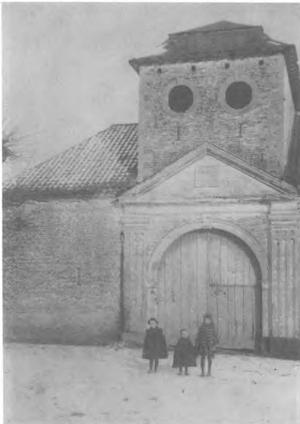
Linkergedeelte van de voorgevel (herenpoort) in noord-westelijke richting.
